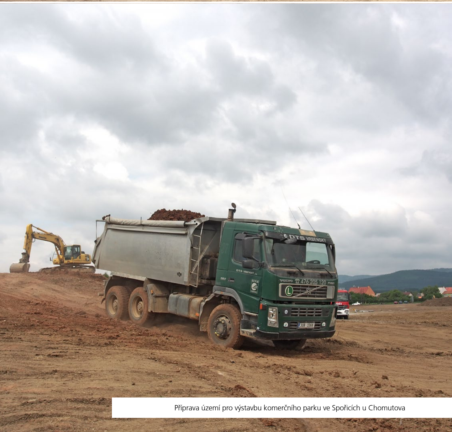
Příprava území pro výstavbu komerčního parku ve Spořicích u Chomutova
