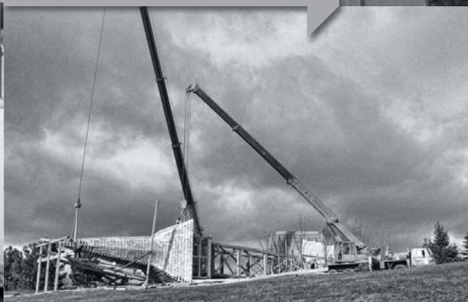
Jeřábníkové práce Liebherr LTM 1070 a Liebherr LTM 1050 Vztyčování věže pravoslavného kostela Most
