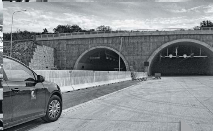
Pohled na portály tunelů Silniční okruh kolem Prahy, stavba 513 Vestec-Lahovice
